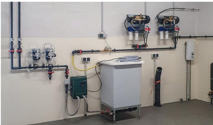
Dieses System bietet die Möglichkeit, mehrere Pumpen hintereinander oder parallel zu schalten und so z.B. eine Chlorsäure- oder Chlordioxid-Dosierung zuzuführen. Durch Parallel-Schaltungen sind Dosierungen von 1% bis 10% möglich. Das alles wird mit nur einem Wasserzähler erreicht.
