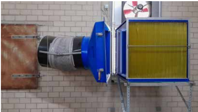
Wärmetauscher in Servicephase
