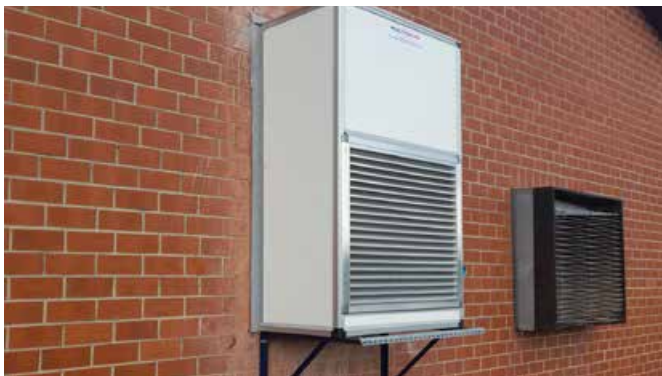
Montage ohne Bodenplatte
